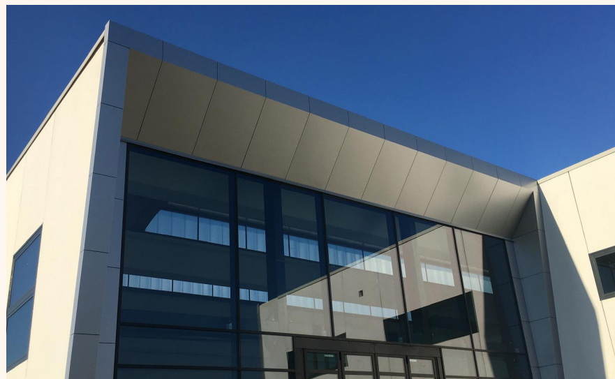
Sopra una realizzazione di infissi realizzata da Ca.ri.ma.
